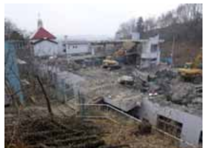
解体が進む園舎
