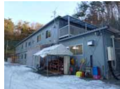
平成 23 年 12 月から仮設園舎の生活が始まった
