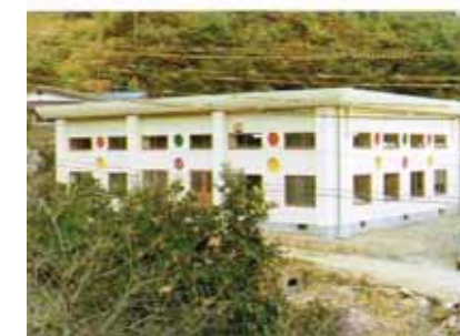
完成した体育館
