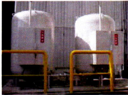
LPG バルクタンク LPG Bulk tank
