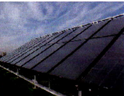
太陽熱パネル Solar thermal panel
