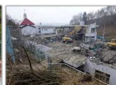
解体が進む園舎
