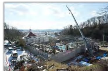
新園舎の工事が始まる
