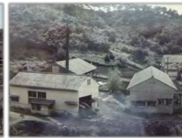
開設当時の園舎（北側から望む）
