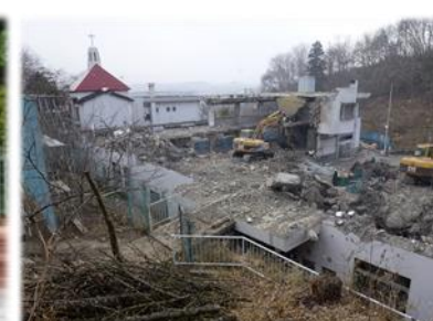
解体が進む園舎
