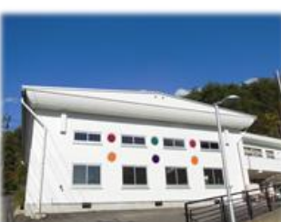
改修を終えた体育館
