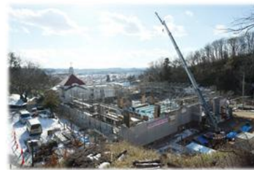
新園舎の工事が始まる
