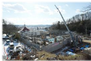
新園舎の工事が始まる
