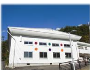
改修を終えた体育館
