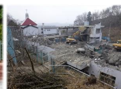
解体が進む園舎
