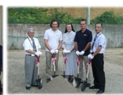
仮設工事の無事を祈って
